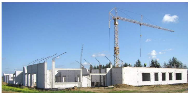
Budowa przedszkola we Wręczycy Wielkiej
