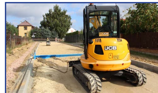
Prace przy modernizacji drogi.
