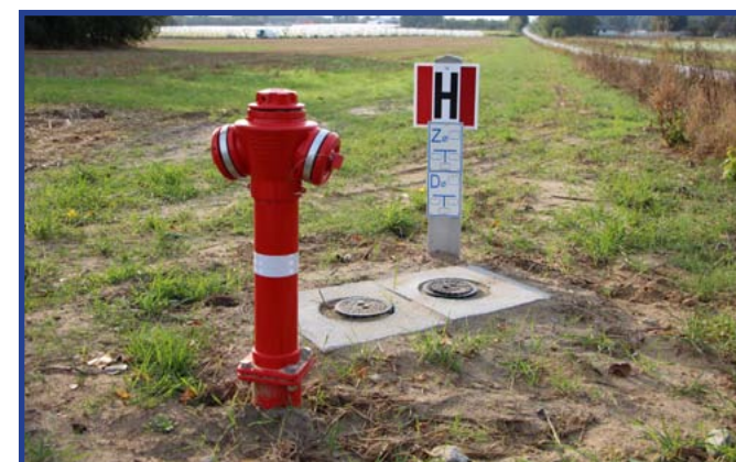
W ramach rozbudowy sieci wodociągowej, pojawiły się także hydranty przeciwpożarowe.
