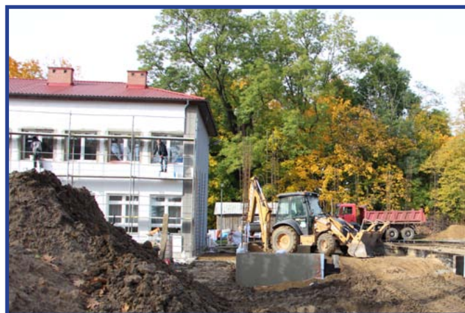
Ku końcowi zbliżają się prace ziemne związane z rozbudową placówki.
