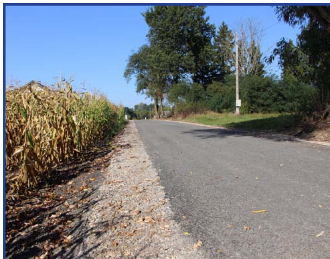
Zmodernizowana nawierzchnia drogi w Studzienicach.
