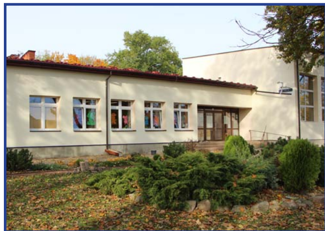
Obecny stan prac przy ociepleniu budynku.
