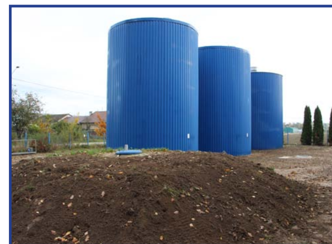
Na terenie stacji uzdatniania wody w Glinicach pojawiła się druga studnia głębinowa.
