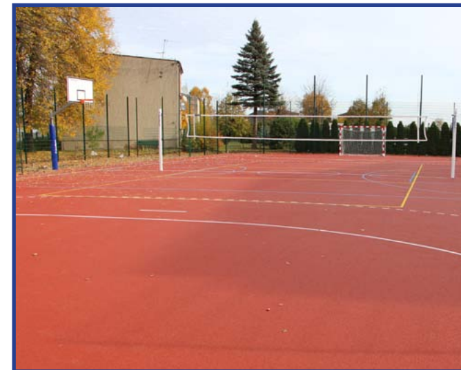
Boisko po modernizacji.
