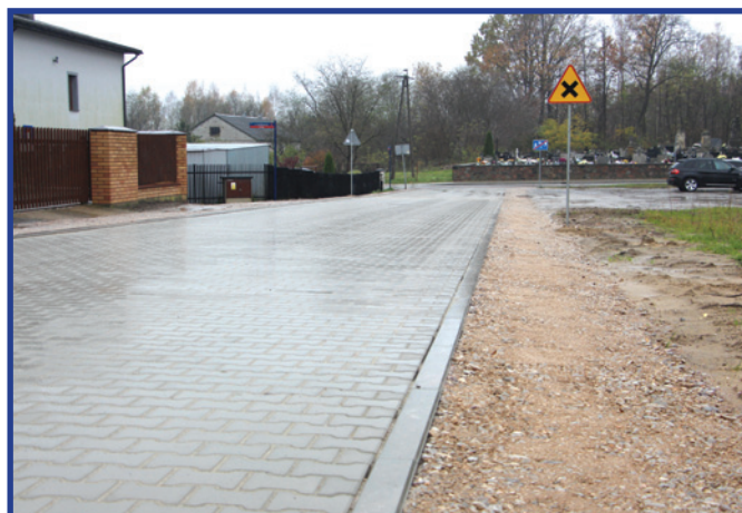
Efekty prac prowadzonych przy przebudowie ul. Mikołaja Reja w Przytyku.
