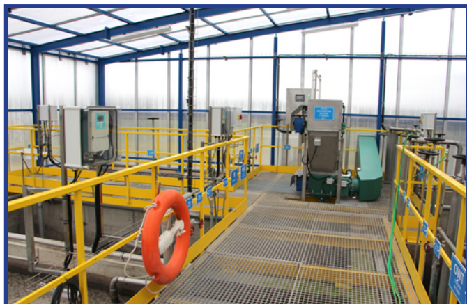
Zmodernizowana hala technologiczna.
