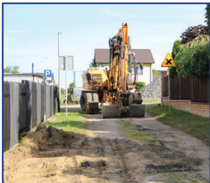
Ulica Henryka Sienkiewicza to ostatnia droga gruntowa na przyszłokolnym osiedlu, która zyska nową, brukowaną nawierzchnię.
