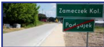
To jedna z wielu wyremontowanych dróg w gminie.
