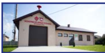
Od podstaw została zbudowana siedziba Ochotniczej Straży Pożarnej we Wrzeszczowie.
