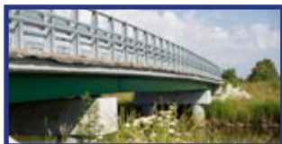
Żelbetonowy most stanął w Sukowskiej Woli na Radomce. Jesienią 2013 roku most został poświęcony i przekazany do użytku.
