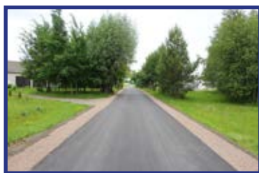
Jest już nowa droga w miejscowości Wola Wrzeszczowska do granicy z gminą Potworów.
