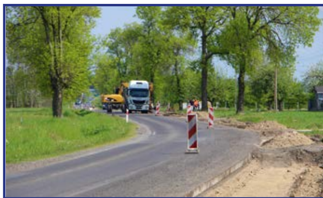
Prace przy modernizacji drogi.
