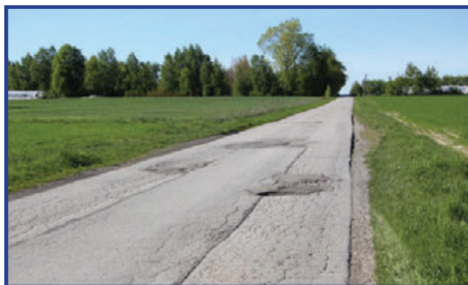
Obecny stan nawierzchni jezdni, która poddana zostanie modernizacji.
