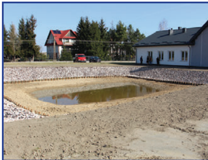
Zmodernizowany zbiornik w Goszczewicach – miejsce z nowym potencjałem rekreacyjnym i ekologicznym.
