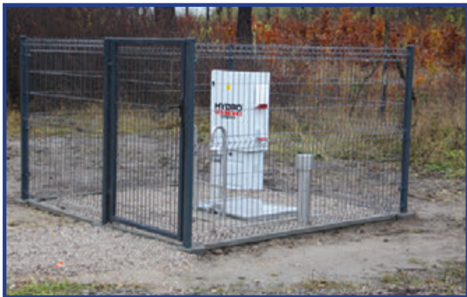
Pod koniec roku 2023 nasz samorząd oddał do użytków mieszkańców kolejny odcinek sieci kanalizacyjnej wybudowanej w miejscowości Oblas.
