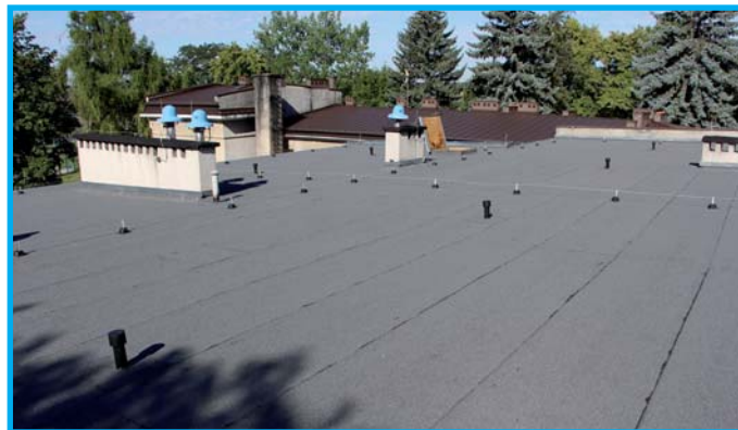
Jest nowy dach na budynku sali sportowej szkoły we Wrzosie
