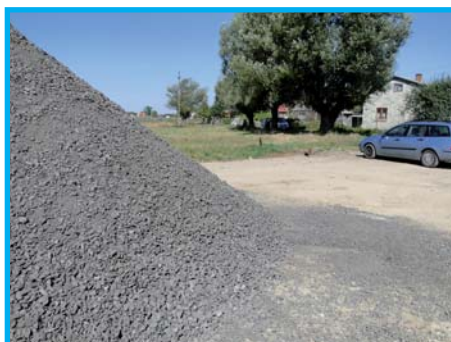
Materiały zgromadzone na budowę drogi w Wygnanowie.
