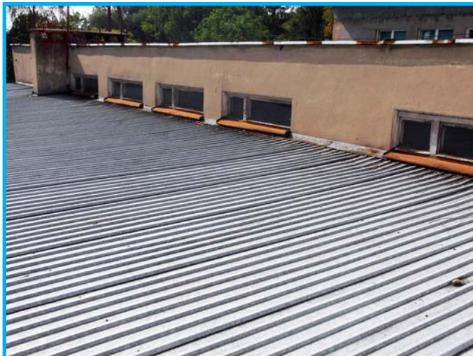
Szkoła podstawowa we Wrzeszczowie będzie miała nowy dach.
