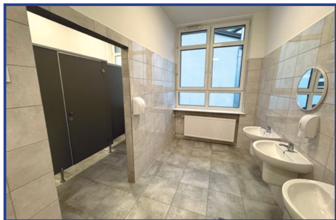
Remont przeszły także toalety dla uczniów.
