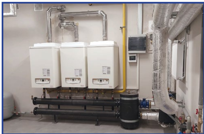
W kotłowni placówki wymieniono dotychczasowe kotły. W ich miejsce zamontowano piecy gazowe.
