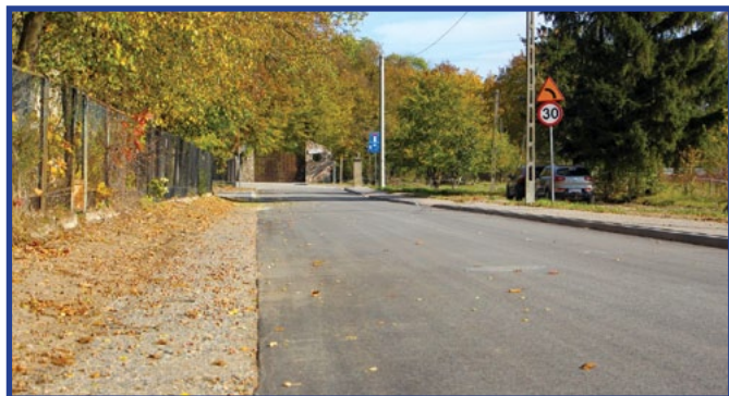
Na tym odcinku drogi ułożono nową nawierzchnię, zmodernizowano chodnik oraz utwardzono pobocza.
