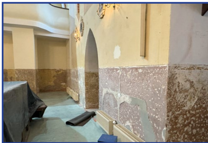
Na remont kościoła parafialnego we Wrzosie, Urząd Miejski w Przytyku pozyskał dofinansowanie z rządowego Funduszu Polski Ład w wysokości prawie 700 tysięcy złotych, co stanowi 98% wartości zadania.
