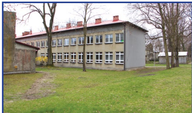
Wygląd placówki przed remontem.
