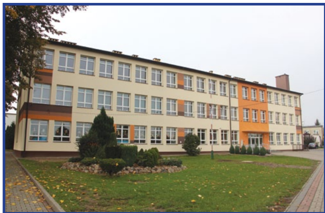
Budynek PSP w Przytyku przeszedł gruntowną termomodernizację.
