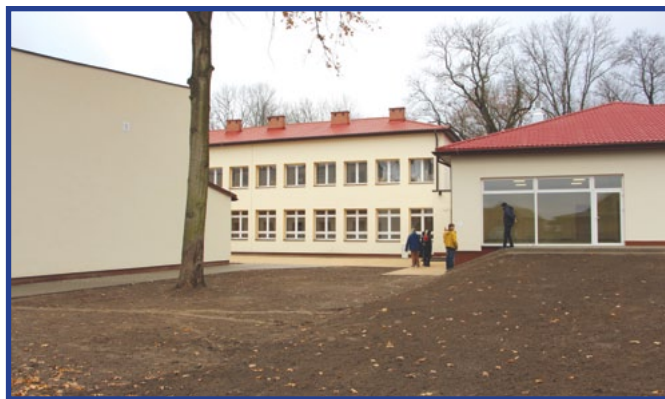
Efekty rozbudowy i termomodernizacji szkoły we Wrzeszczowie.
