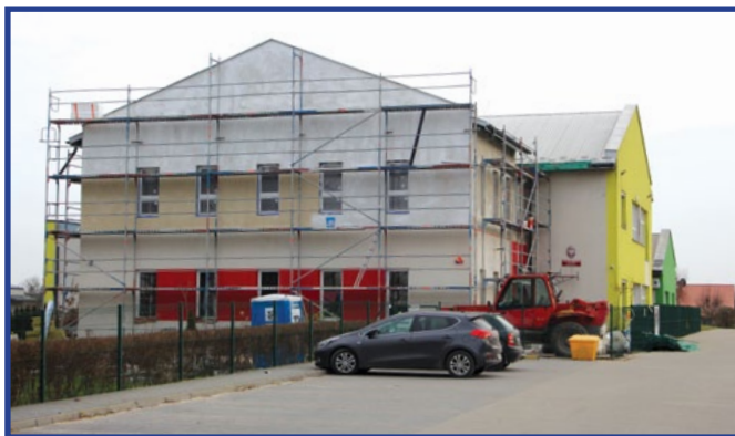
W ramach podpisanej umowy, wykonawca zrealizuje również zakup i montaż wyposażenia przedszkola.
