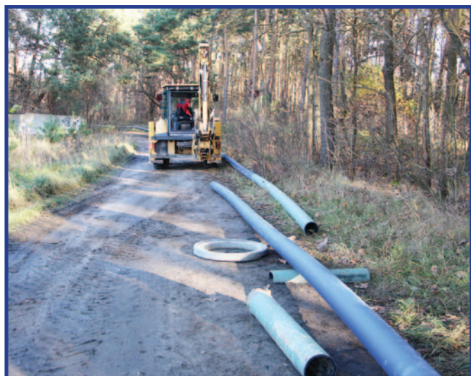
Prace przy budowie sieci kanalizacyjnej.
