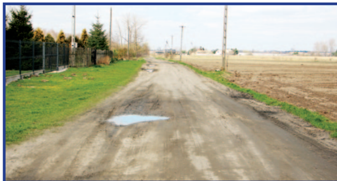
Obecny stan drogi w miejscowości Wygnanów (Wygnanów Pomorze).
