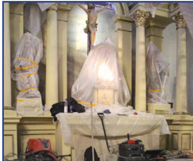
Wnętrze kościoła we Wrzeszczowie, gdzie przeprowadzane są prace renowacyjne.
