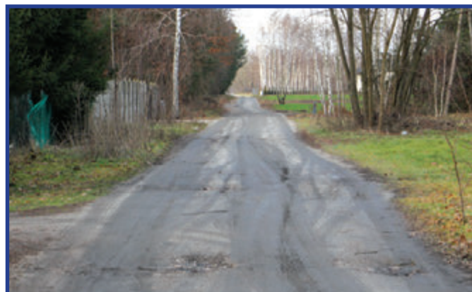
Obecny stan drogi.
