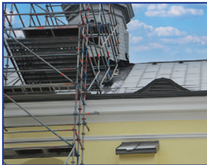
Wymiana pokrycia dachowego na blachę tytanową, pozwoli na zabezpieczenie świątyni przed warunkami atmosferycznymi na kolejne lata.
