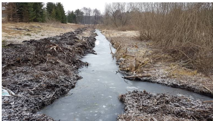
Zdj.6. Obszar opracowania – przywracana melioracja szczegółowa na terenie opracowania – pogłębiony i udrożniony rów melioracyjny.
