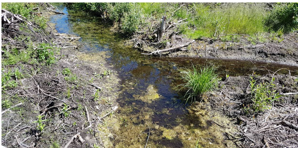
Zdj.3. Obszar opracowania i tereny ościenne – przywracana melioracja szczegółowa na terenie opracowania – pogłębiony i udrożniony rów melioracyjny.
